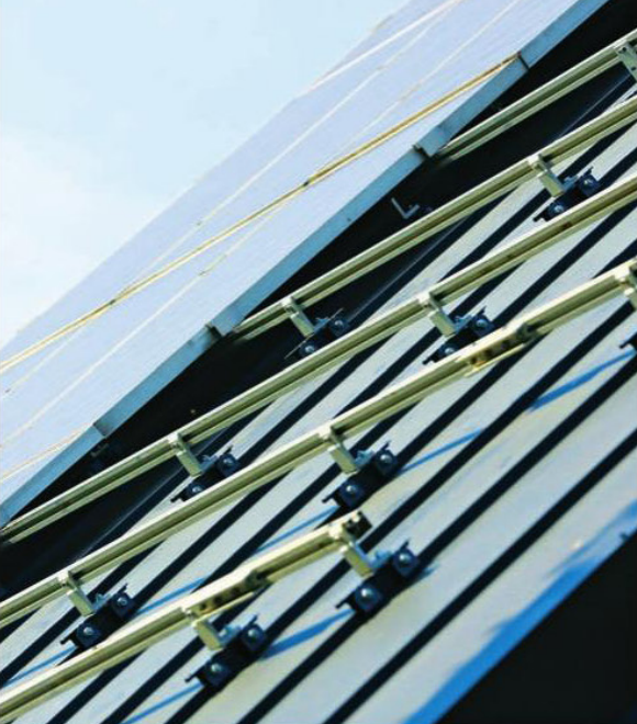
EFEKTIVITA SOLÁRNÍ ELEKTRÁRNY
